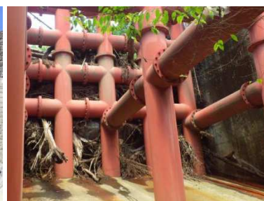
写真 4 新所 2 (下流より見る)
