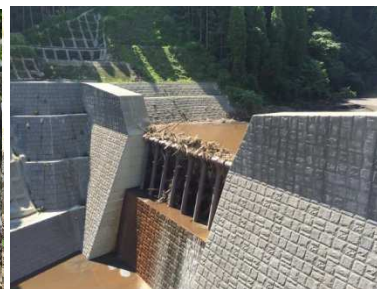
写真 2 仮川 (下流より見る)
