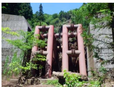
写真 1 東下田川 2 (下流より見る)
