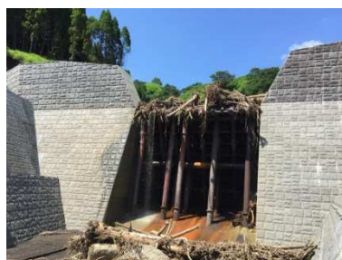
写真 3 仮川 2 号 (下流より見る)
