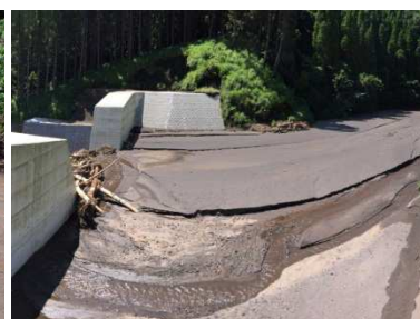
写真 6 仮川 (堆砂状況)
