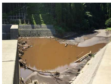
写真 7 仮川 2 号 (堆砂状況)
