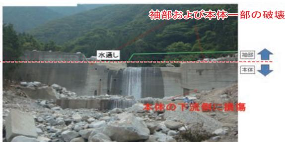
写真-1 コンクリート砂防堰堤本体および袖部の破壊
