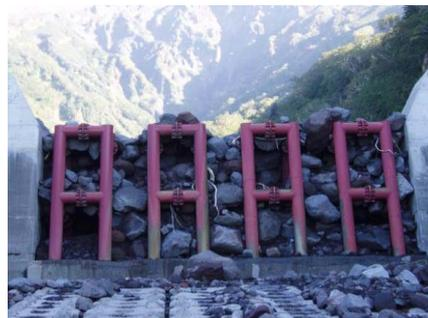
写真-1 鋼製透過型砂防堰堤による礫の捕捉
