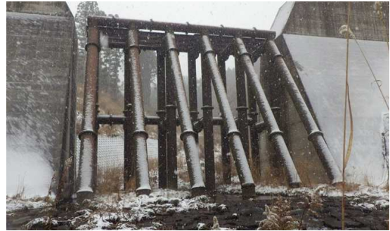
写真-1.2 新湯川砂防堰堤（平成28年調査時）
