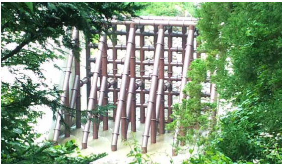
写真-2.1 幕川砂防堰堤（平成23年竣工直後）
