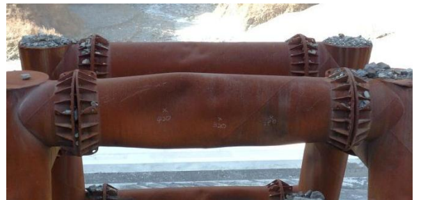
b) フランジ継手間衝突型(上流視)
