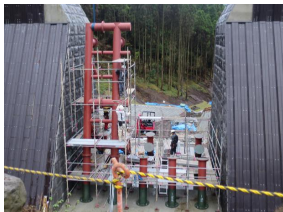
写真-1 鋼製透過型砂防堰堤の現地組立状況
