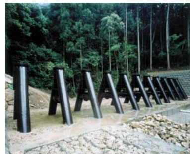
写真-1 河床上に単独設置された流木捕捉工
