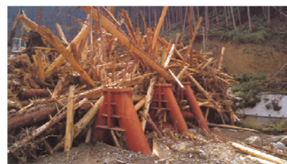
写真-2 流木捕捉工による流木の捕捉事例
