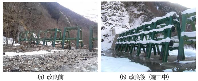
写真-2 縦部材+横部材の追加事例
