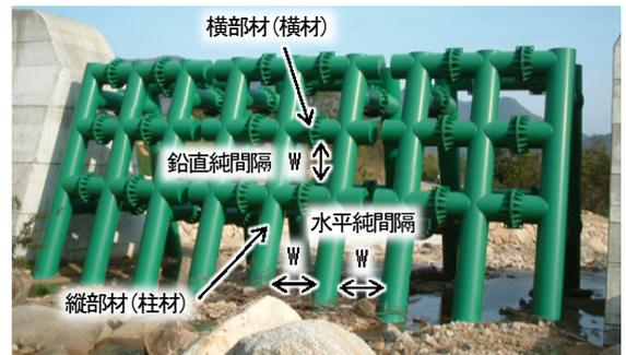
(b) 改定後: 最大礫径  $D_{95}=1.0\text{m}$ , 鋼管純間隔  $W=1.0\text{m}$
