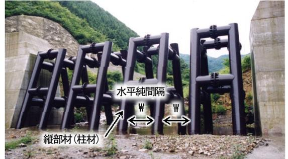
(a) 改定前: 最大礫径  $D_{95}=1.0\text{m}$ , 鋼管純間隔  $W=1.5\text{m}$
