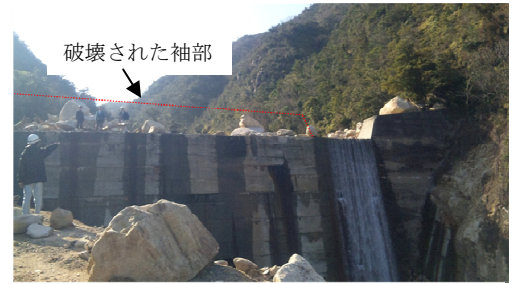
写真-1 コンクリート砂防堰堤袖部の破壊
