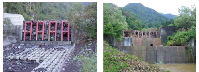
写真-3 堰堤改良後の土石流・流木捕捉事例
