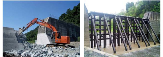
(a) 改良中 (b) 改良後 写真-1 不透過型コンクリート砂防堰堤の改良事例
