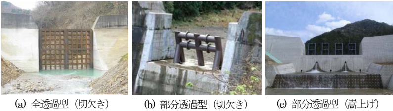
写真-2 改良型式別の設置事例
