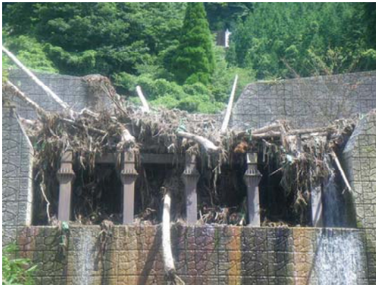
写真2 土砂・流木の捕捉状況 (平保の木川堰堤)
