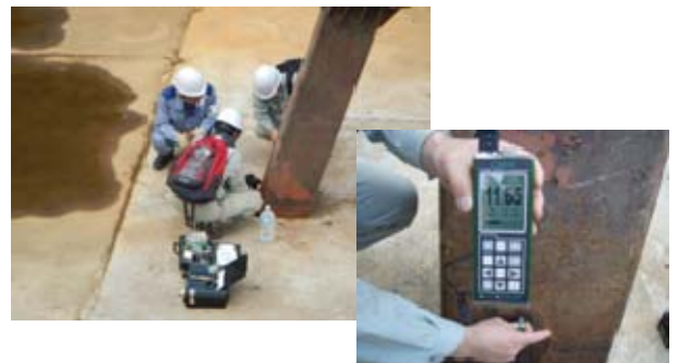
板厚測定状況
