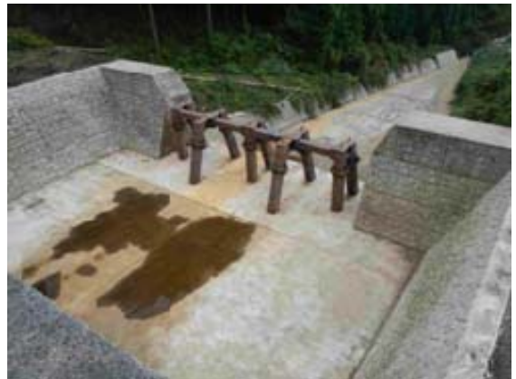
除石・除木の状況
