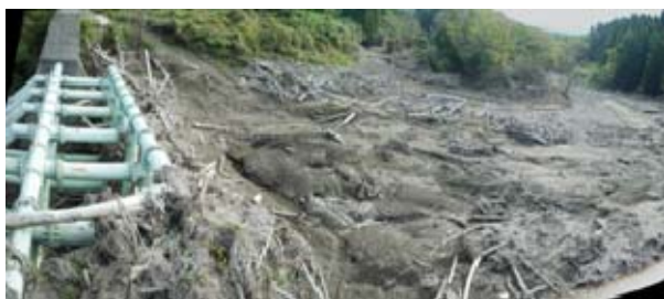
上流側の状況
