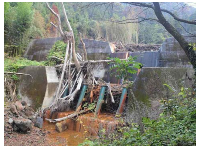
写真1 土砂・流木の捕捉状況 (塩井川2堰堤)
