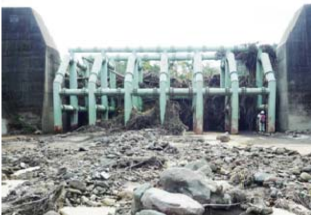
開口部の状況
