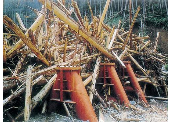
写真-1 流木捕捉工による流木捕捉事例
