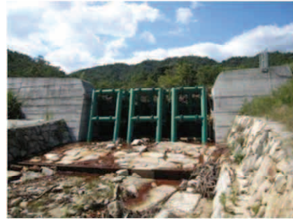
写真-1 透過型砂防堰堤
