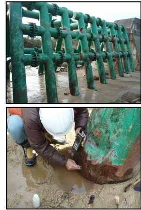
写真-3 B型損傷調査状況
