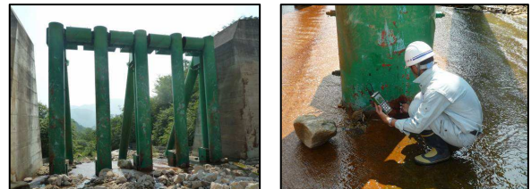
写真-2 I 型損傷調査状況
