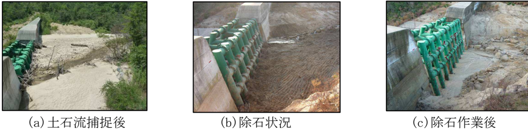
写真-1 鋼製透過型砂防堰堤(B型)の除石状況
