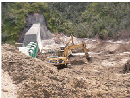
写真-3 掘削状況
