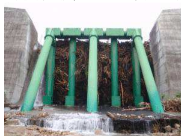
(a)I型スリットえん堤
