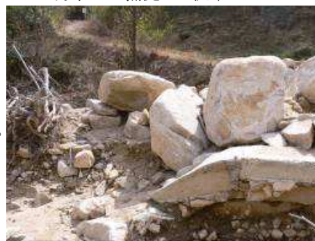
写真-5 上流側に堆積した礫群の状況
