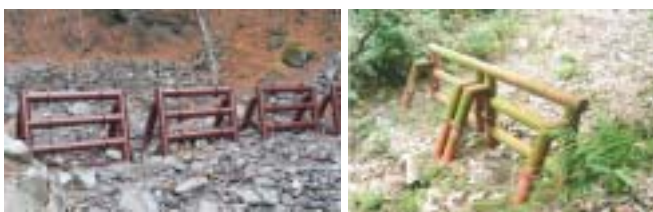
写真-1 コンクリート基礎を持たない構造物
