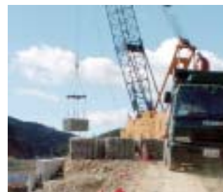
写真-3 吊り状況
