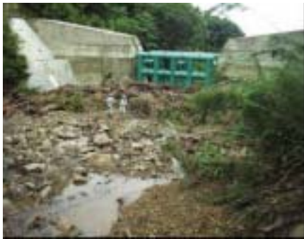
写真-1 礫と流木が混合した状態での捕捉状況 (国土交通省ホームページより)
