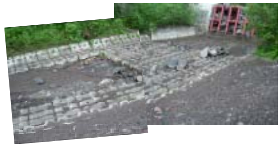
写真-3 本えん堤の下流側堆砂状況
