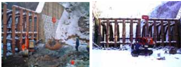
写真3 索道による除石の事例
