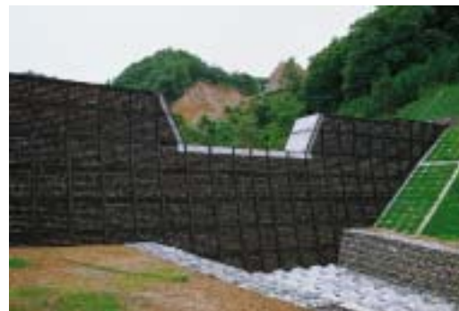
写真-1 鋼製枠砂防えん堤
