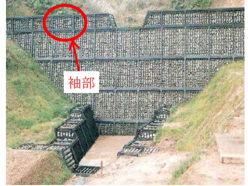
写真-1 鋼製枠砂防えん堤
