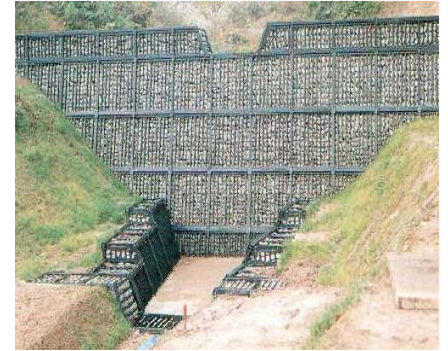
写真-1 鋼製枠砂防えん堤
