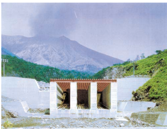
野尻川 平成2年[大隅工事事務所]
