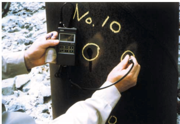
板厚測定状況(最上流部の鋼管健全部)
