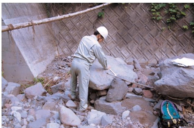
礫径調査状況( 礫による損傷調査 )
