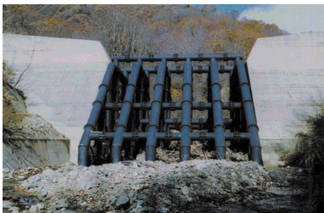
全景( 構造物全体の目視調査 )
