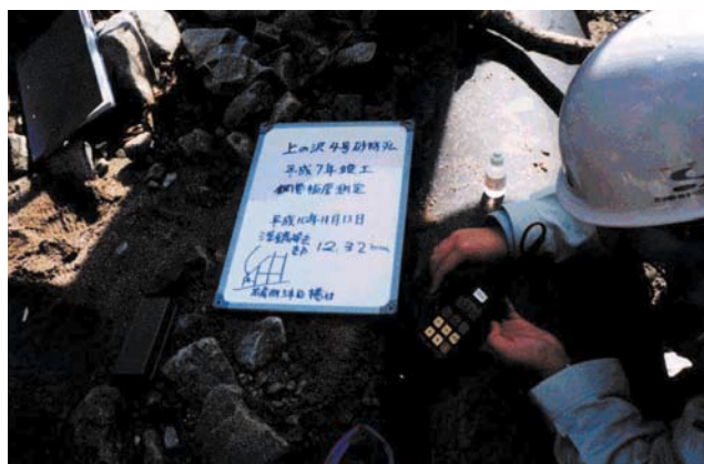
板厚測定状況( 板厚の点検・調査 )
