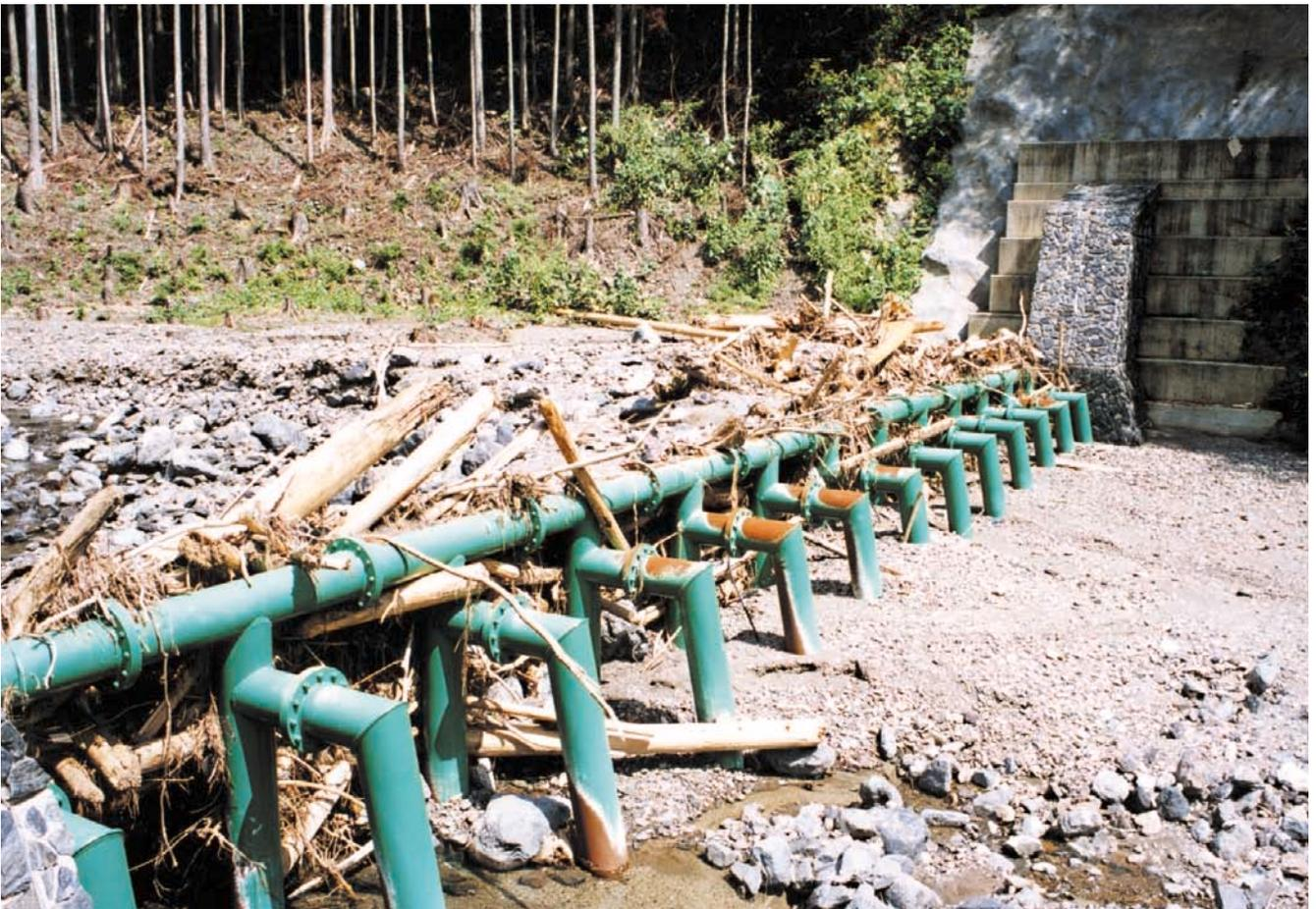
宮谷川3号流木止工 鋼製部高3m、鋼製部幅24m、水通し幅25m(21.2トン) 平成11年設置
