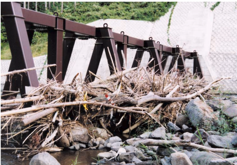
中原川 鋼製部高3m 平成5年度[ 熊本県 ]
