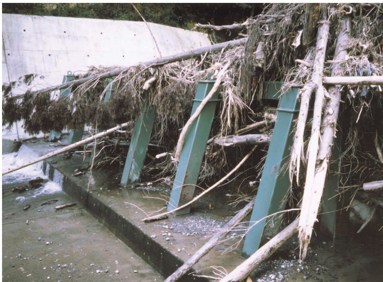
高瀬川 鋼製部高3m 平成5年度[大分県]
