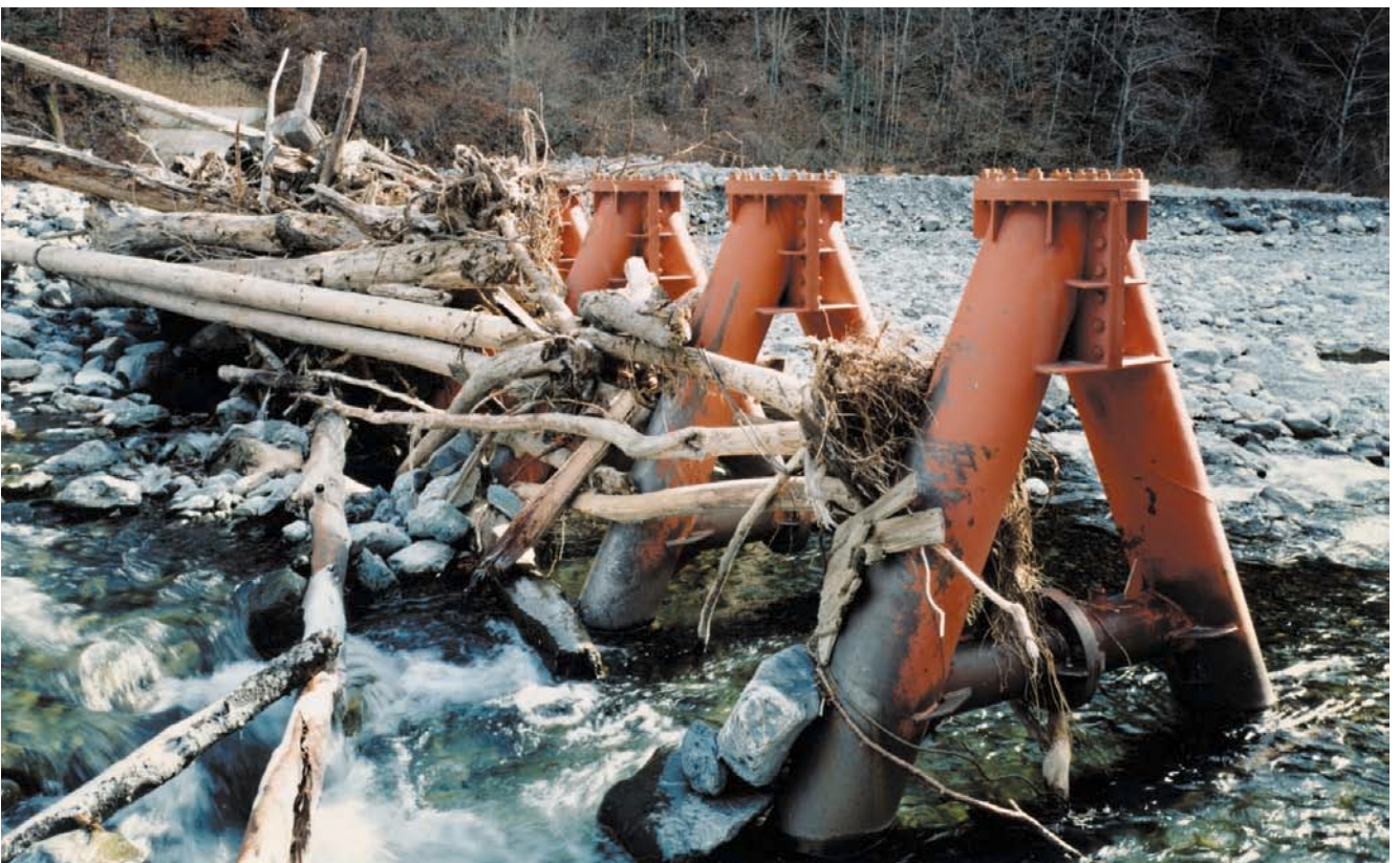
三峯川 伊那谷の長大、太径の流木捕捉 鋼製部高3m[ 長野県 ]
