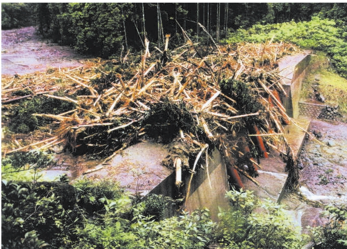
対策後流木を捕捉した。設置場所は上写真の位置近く 鋼製部高3m 平成5年 [ 熊本県 ]
