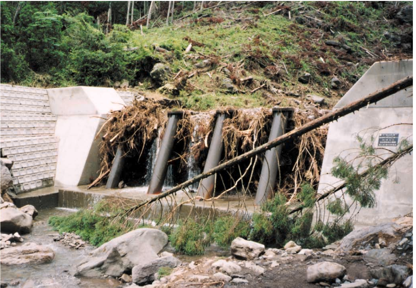
宇土谷 鋼製部高3m 平成4年[ 熊本県 ]
