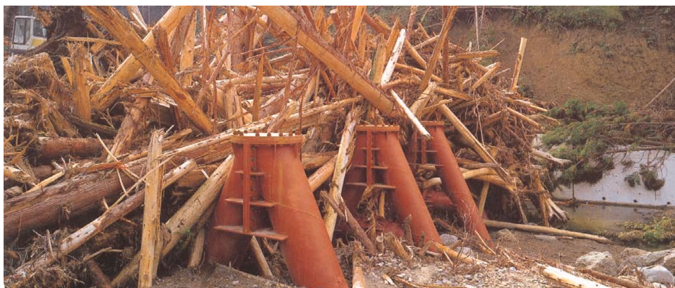
屋形川(上流側えん堤) 対策後のスリットえん堤により捕捉された流木 鋼製部高3m・4m 平成5年[大分県]
