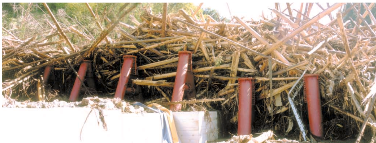
屋形川(下流側えん堤) 捕捉した流木を下流側から見た状況 鋼製部高3m・4m 平成5年[大分県]
