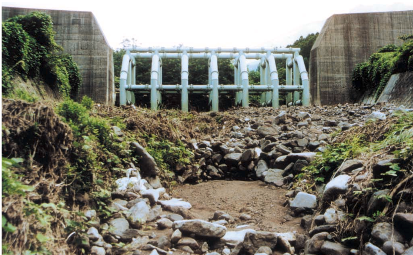
流木を捕捉した古恵川第9号砂防えん堤 平成3年〔熊本県〕 鋼製部高8m、全幅155m、鋼製部幅17.4m、水通し幅21m(105トン)
