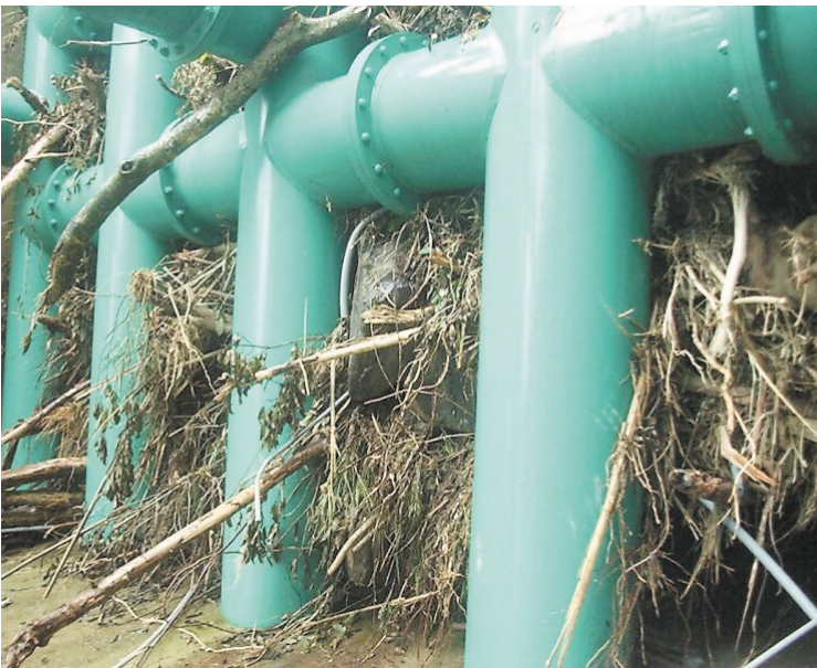
軍場川砂防えん堤 鋼製部高9m、全幅49m、鋼製部幅6.4m、水通し幅8m(81.2トン) 平成11年[鹿児島県] 平成13年の台風による流木を捕捉
