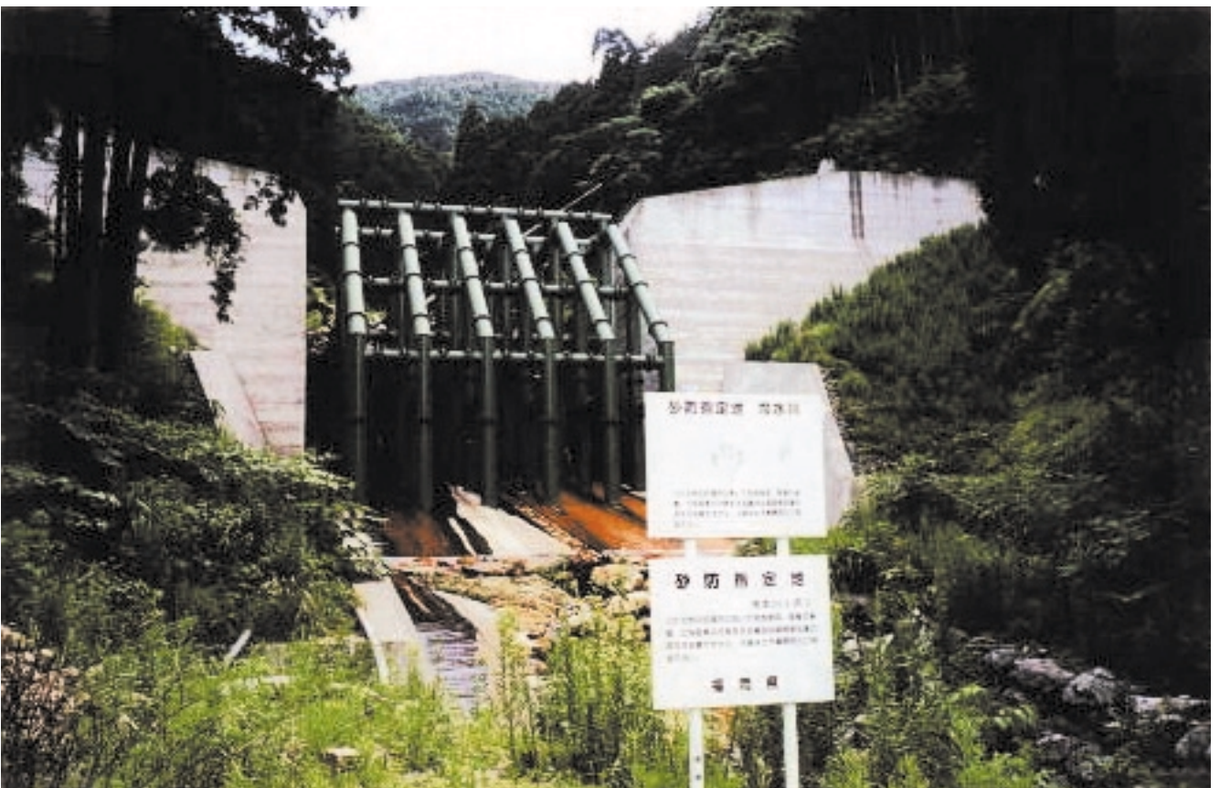
冷水川砂防えん堤 鋼製部高11.5m、全幅63m、鋼製部幅11.5m、水通し幅15m(139.8トン) 平成4年[福岡県]
