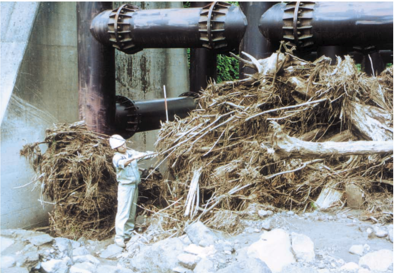
流木を捕捉した古恵川2号砂防えん堤 鋼製部高8m、全幅190m、鋼製部幅87m、水通し幅12m(58.1トン) 平成5年[熊本県]
