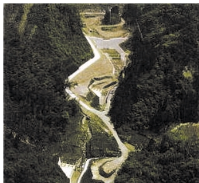
対策完了後の全景
