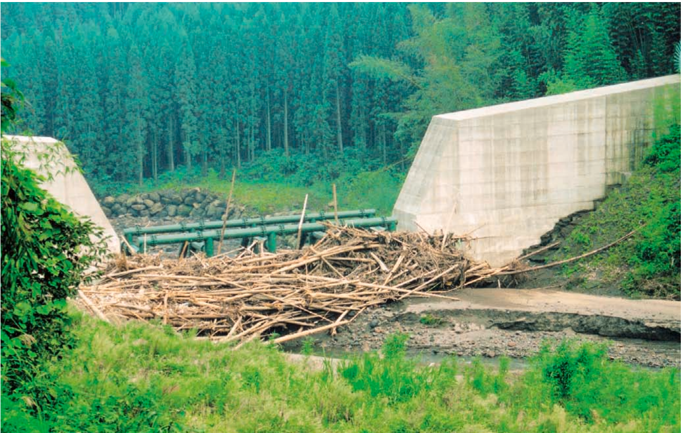
平成3年9月の豪雨により発生した風倒木を捕捉 滝水川砂防えん堤 鋼製部高11m、全幅99m、鋼製部幅17.6m、水通し幅21m(139.9トン) 平成3年[大分県]
