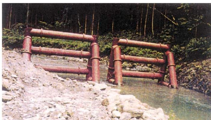
平成11年6月の集中豪雨により、上流の斜面崩壊地から土砂と流木が流出し、緊急対策工事で施行されていた鋼製L型スリットえん堤により捕捉された。当時、上流の斜面崩壊地では対策工事を実施中であったため、仮排水用の暗渠管(直径約2m)も流出し、土砂や流木と併せて捕捉されている。捕捉された土砂・流木は即時に除去され、鋼製L型スリットえん堤の機能(空容量の確保)が回復されている。
