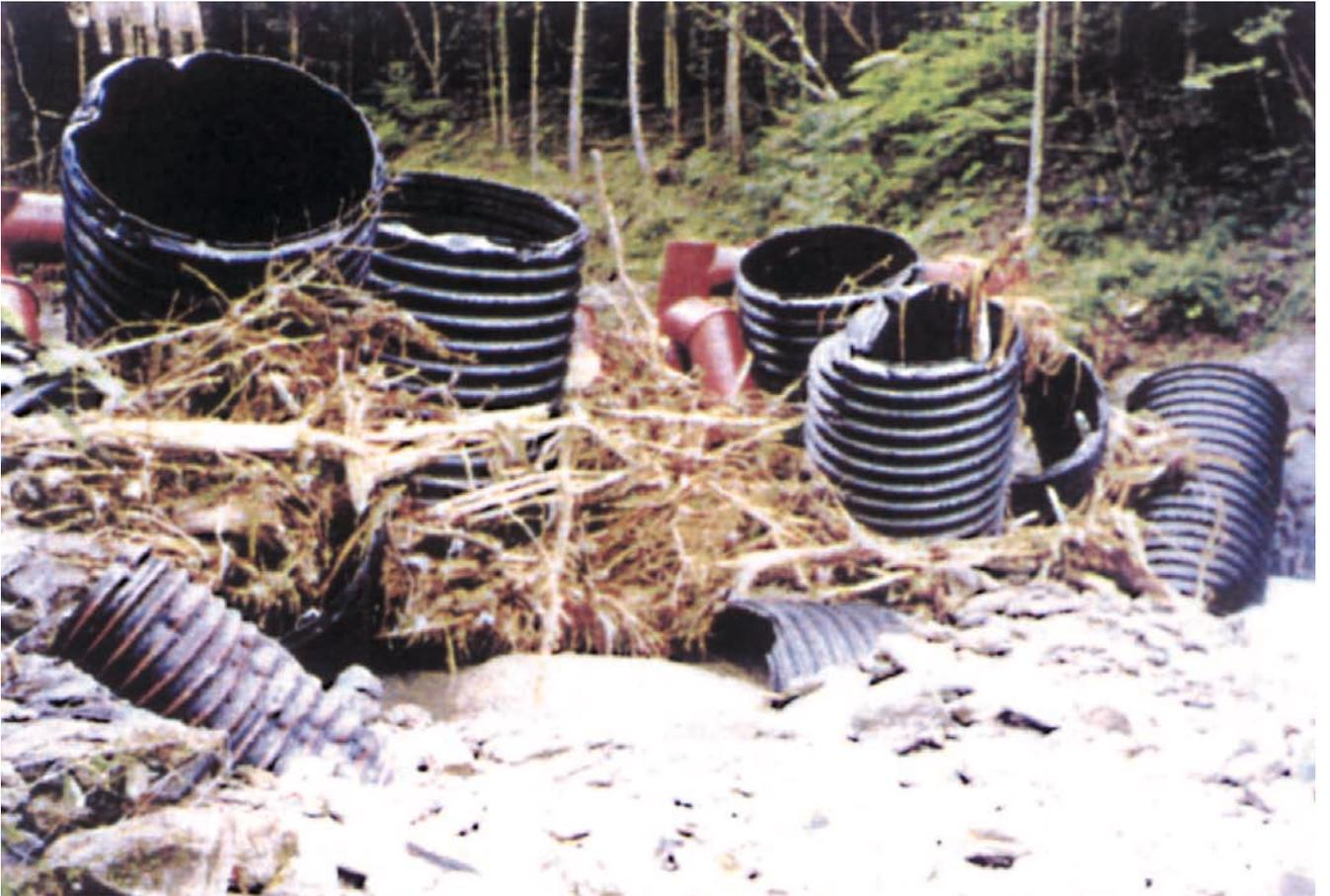
土石流を捕捉した藤川谷川の鋼製L型スリットえん堤 平成10年度[徳島県]
