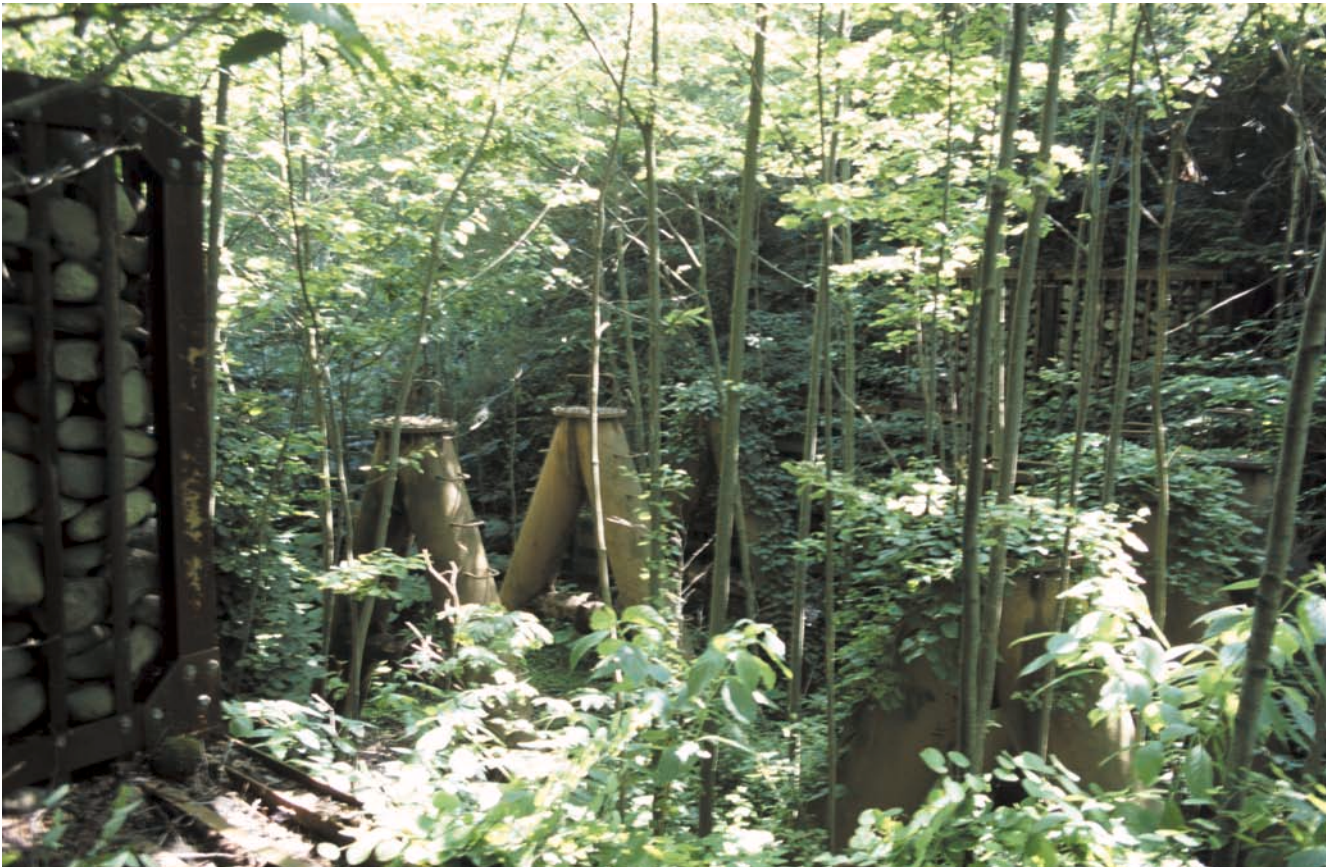
河床が安定している為、植生の回復が著しくえん堤は機能を保持しつつ自然の一部にとけ込んでいる 小有珠右の川 鋼製部高4m 昭和54年設置 平成13年撮影[北海道]
