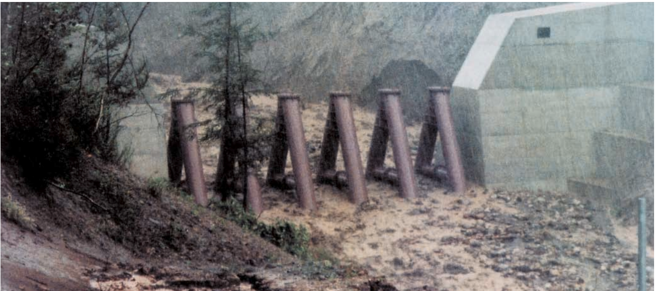
土石流が未だ捕捉されていない初期の段階
