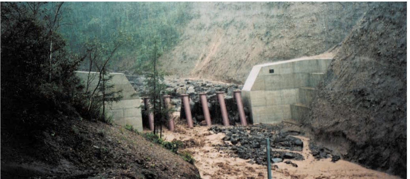
駒ヶ岳の押出沢に発生した土石流を捕捉した 鋼製部高5m 平成8年設置 平成10年撮影 北海道]
