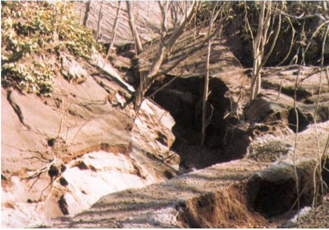
小有珠右の川1号スリットえん堤。10月24日の泥流のさい、転石があった場所である
