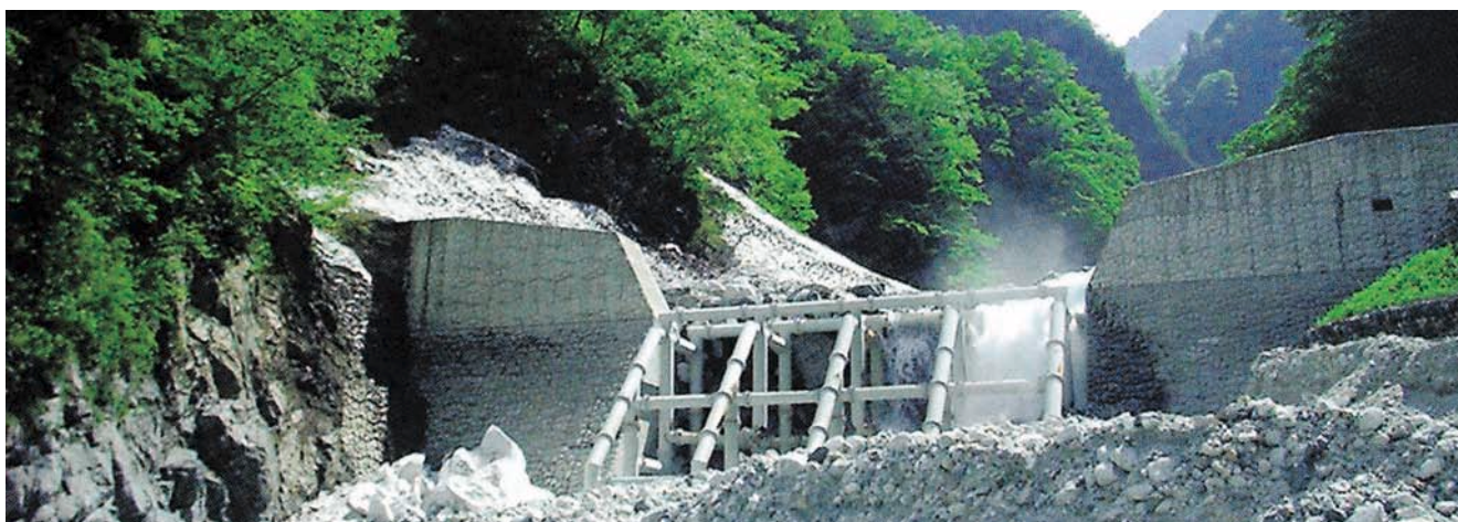
南股第4砂防えん堤 全幅63m、鋼製部高=11m、鋼製部幅=18m、水通し幅20m(150.6トン) 平成7年[松本砂防工事事務所]
