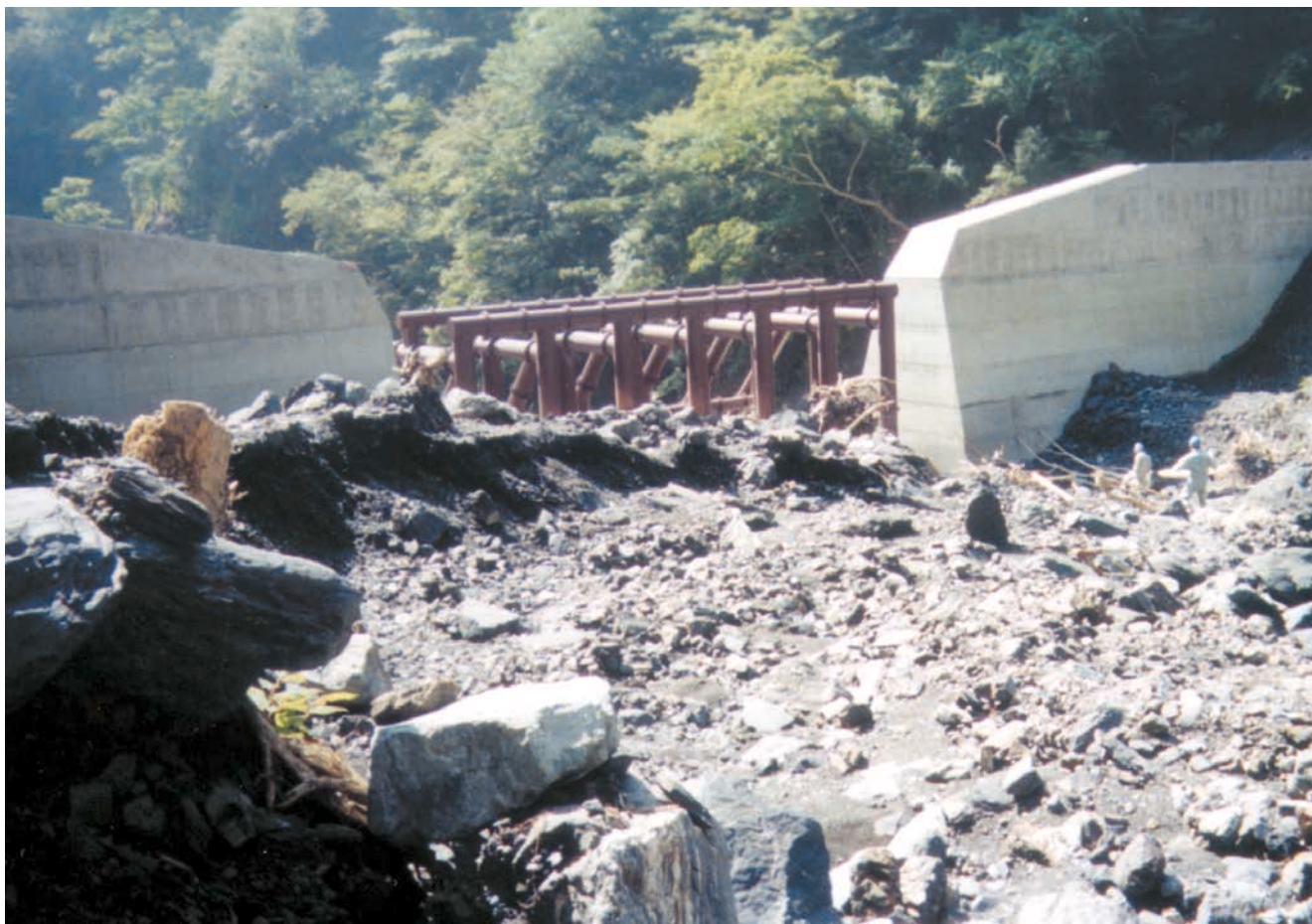
坂本川4号砂防えん堤 鋼製部高12.5m、鋼製部幅15.6m、全幅82m、水通り幅20m(221.8トン) 平成11年[静岡県]
