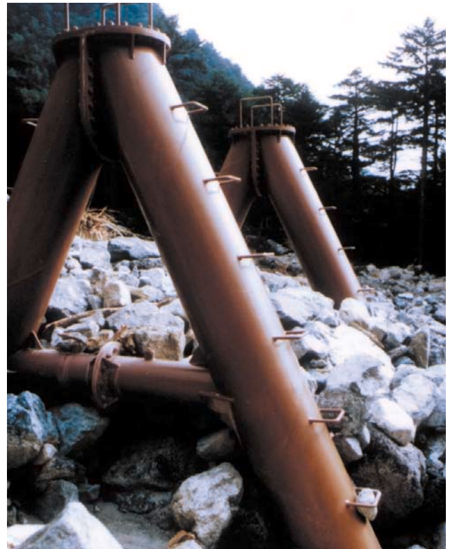
梓川支川八右衛門沢の樹林帯を保護する日本で初めて設置された鋼製スリットえん堤A型 鋼製部高4m 昭和52年[松本砂防工事事務所]
