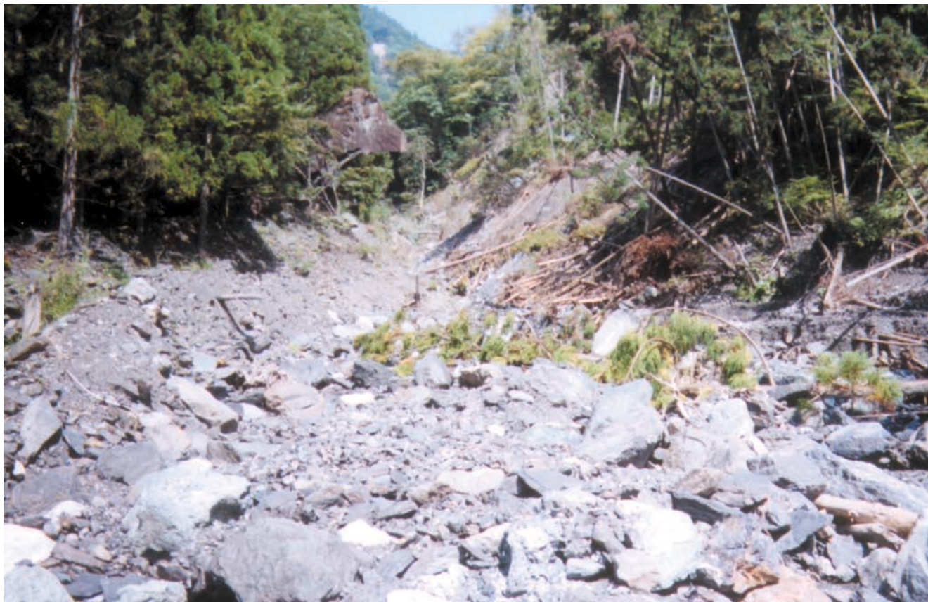
坂本川上流部は倒木と流出土砂が堆積しており、土石流を起こす危険性が高い状態になっている
