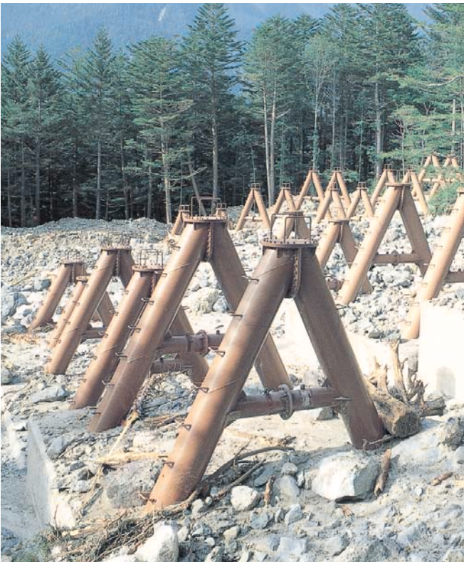
梓川支川八右衛門沢の樹林帯を保護する日本で初めて設置された鋼製スリットえん堤A型 鋼製部高4m 昭和52年[松本砂防工事事務所]
