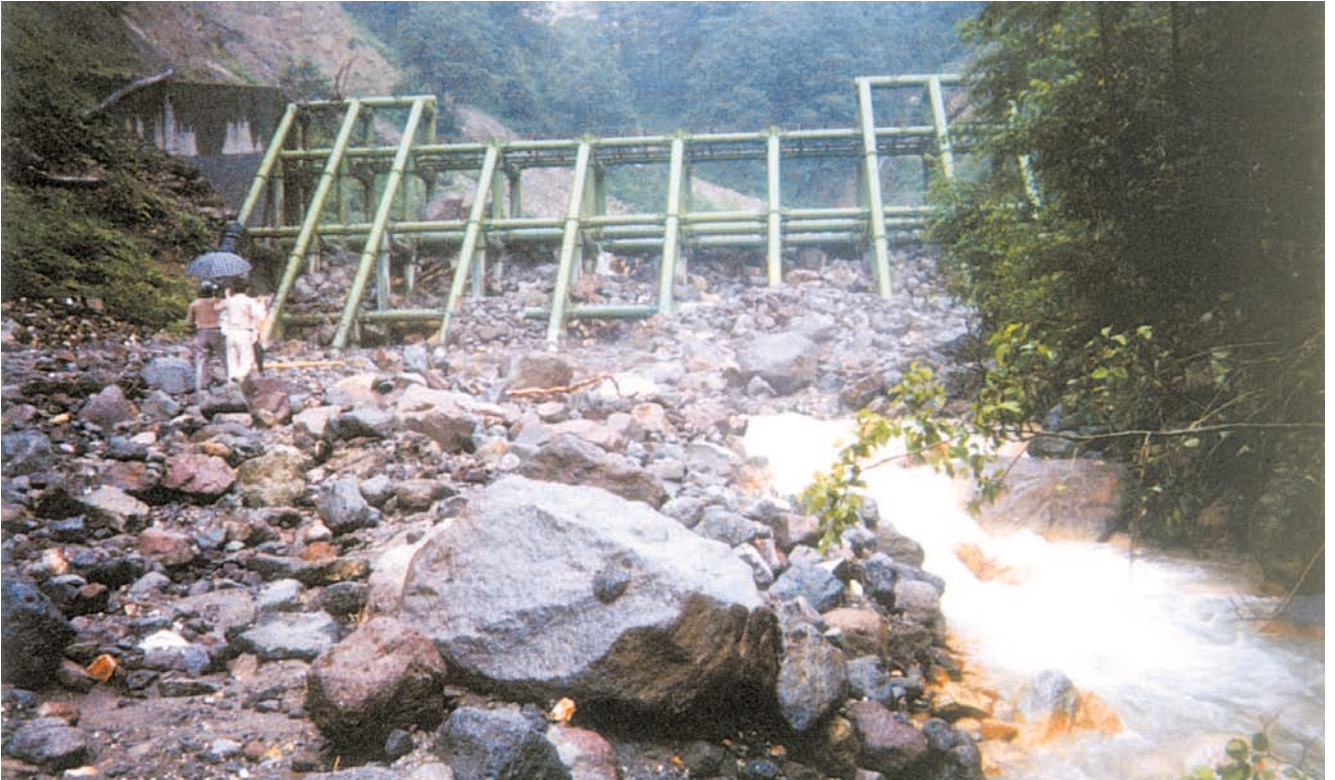
白水谷第2号砂防えん堤 全幅68m、鋼製部高10.2m、鋼製部幅32m、水通し幅19.4m(241.9トン)昭和57年[神通川砂防工事事務所]
