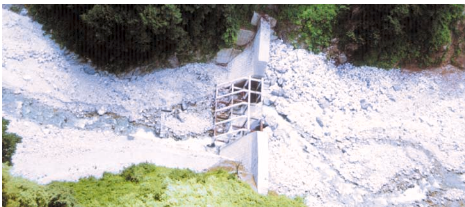
南股第4砂防えん堤 全幅63m、鋼製部高=11m、鋼製部幅=18m、水通し幅20m(150.6トン) 平成7年[松本砂防工事事務所]
