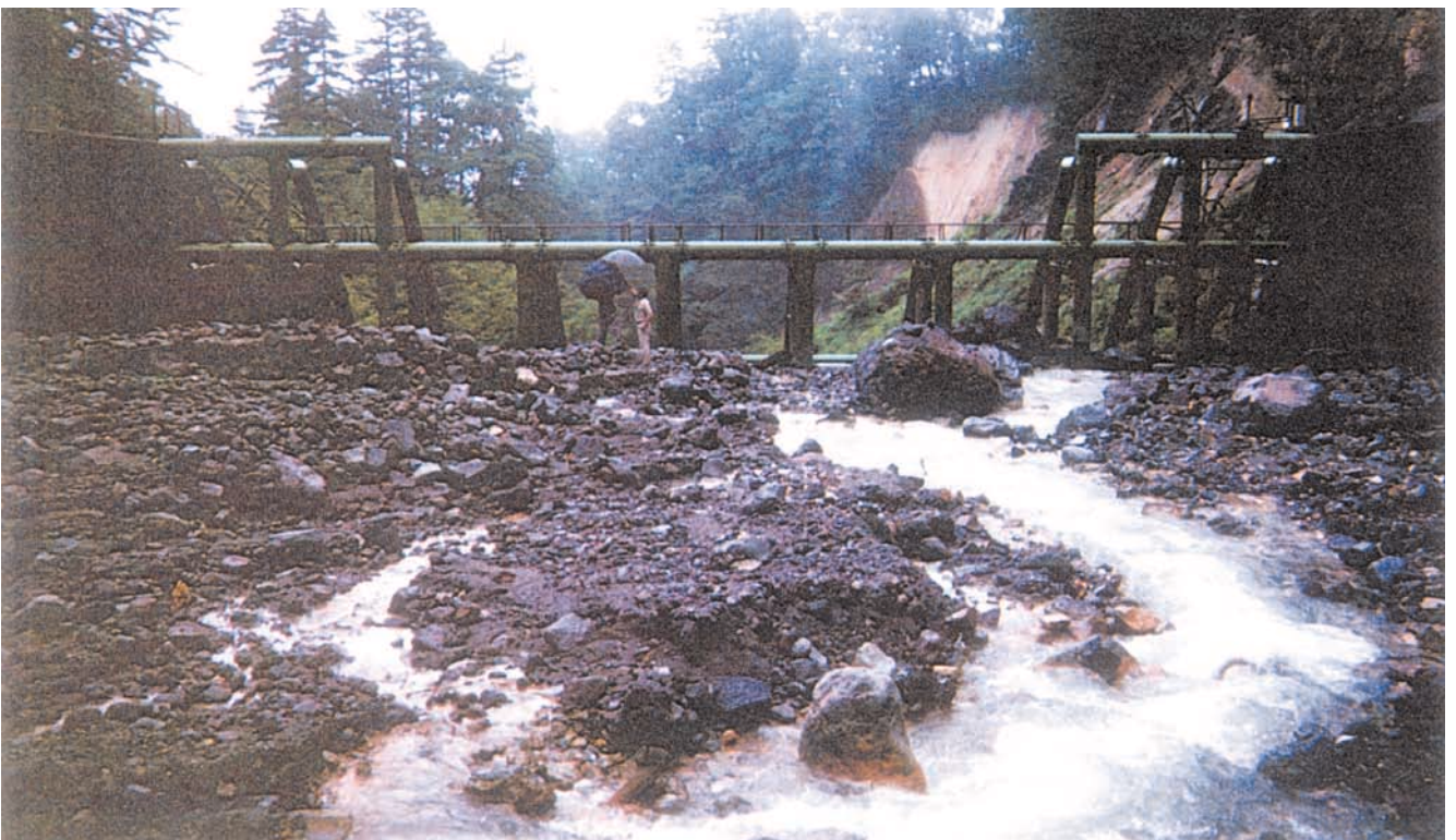
土石流を捕捉した上流側の状況
