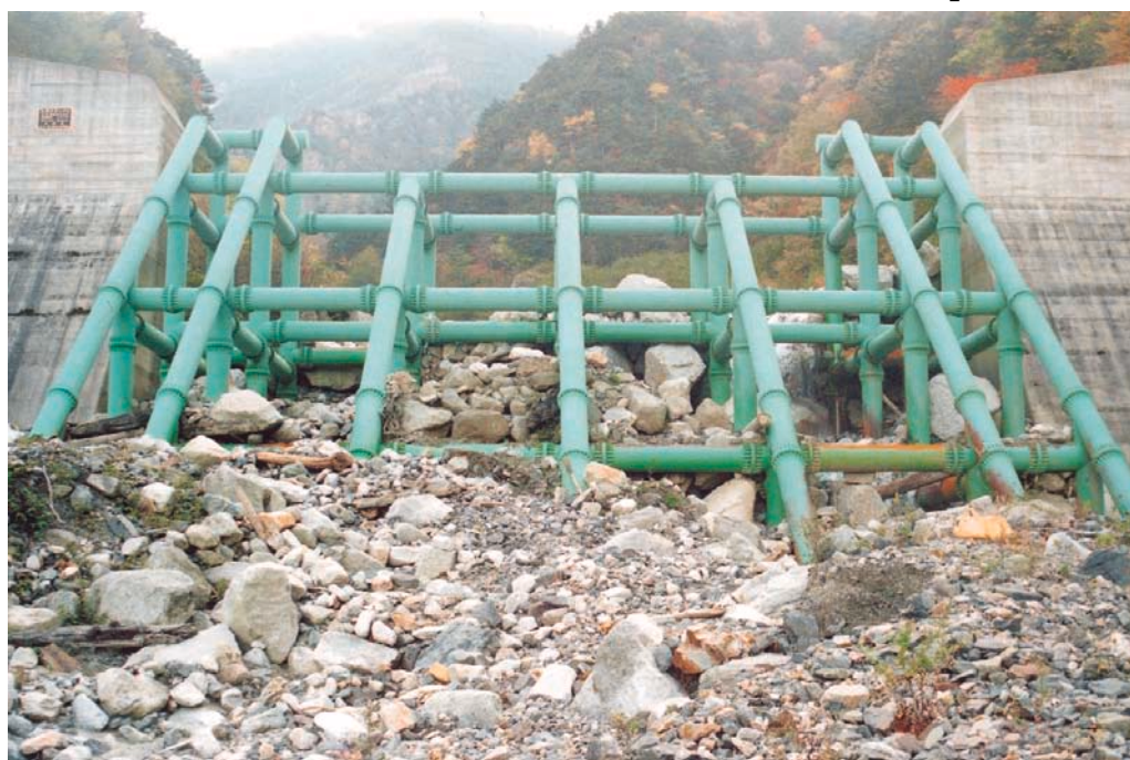
94年10月25日土石流を捕捉し、堆積深は10mを超える 全幅69m、鋼製部高11.5m、鋼製部幅18.4、水通し幅17.8m(321トン)
