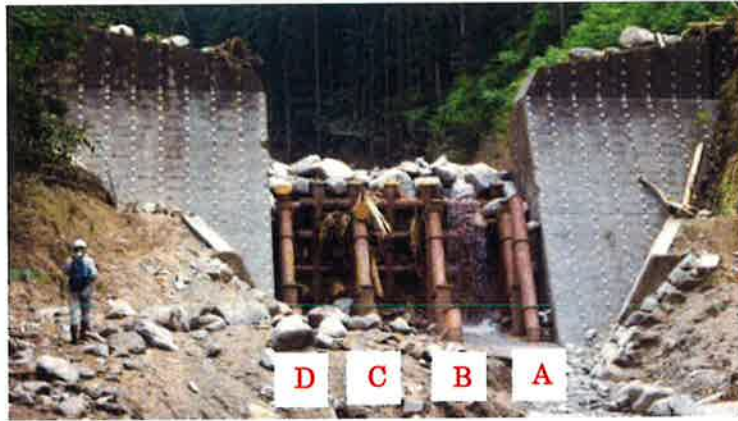
写真1 下流から見た状況
