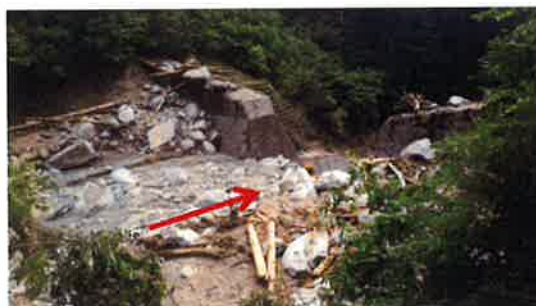
写真4 上流側から見た袖部天端
