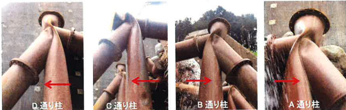
写真3 上流から2列目の柱部分(左側写真から 右岸～左岸 の順)
