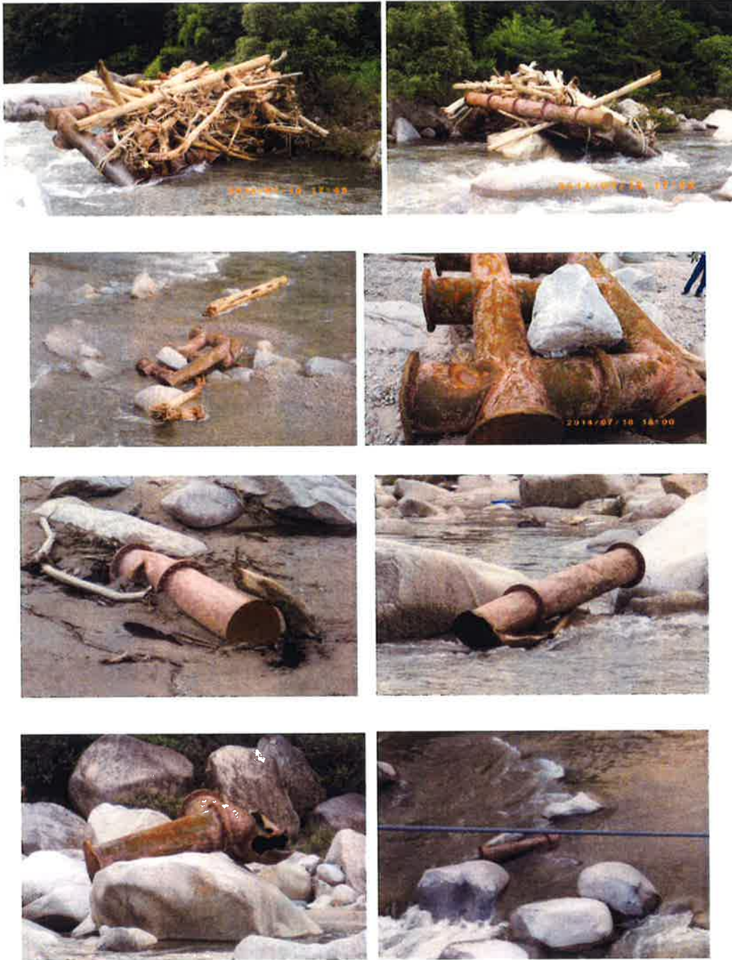
写真5 本川に流出した部材
